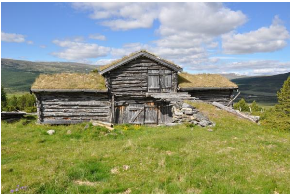
Figur 7.5: Løa på setra til Søre Svendsgard på Tolleivshaugen ble satt i stand på dugnad i 1985. 12 Bygningen fikk nytt tak, og enkelte bunnstokker ble skiftet ut. Løa utmerker seg med den ”skjeve” kjørebua, som forenkler innkjøring i begge etasjer. Bygningen er datert til slutten av 1700-tallet i SEFRAK. Foto: Anne Sætren, NIKU 2010.
