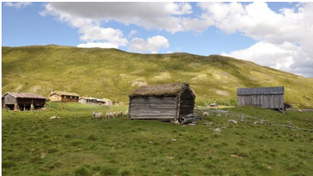
Figur 7.16: På Verkjesæter er kun én av tre stående løer SEFRAK-registrert, og ingen av de to løene på fotografiet. De to løene representerer to tidsfaser i seterbruket, som begge inngår i setringens kulturhistorie, og er viktige for opplevelsen av landskapet. Den lafte løa i midten av bildet er preget av framskredet forfall, mens den yngre løa i reisverk til høyre i bildet er i bedre stand. Foto: Anne Sætren, NIKU, 2010.
