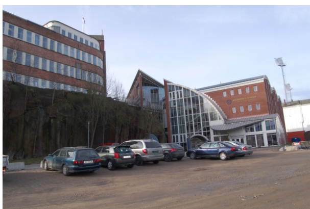
Dagens høyskole består av det tidligere Administrasjonsbygget til FMV, samt nybygg fra 1990-tallet. Foto: NIKU
