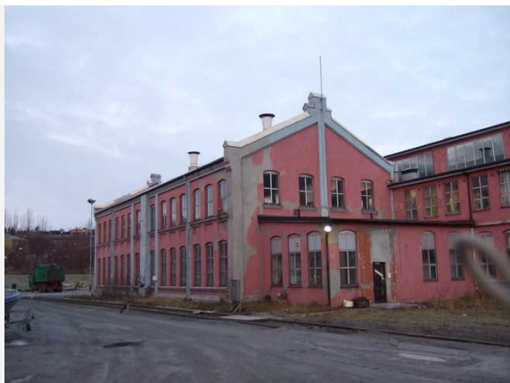
Mekanisk verksted nede ved havnen. Eldste deler fra 1902. Regulert til bevaring. Mulig sted for Teknorama. . Foto: Narvik kommune, Fotosamlinga.
