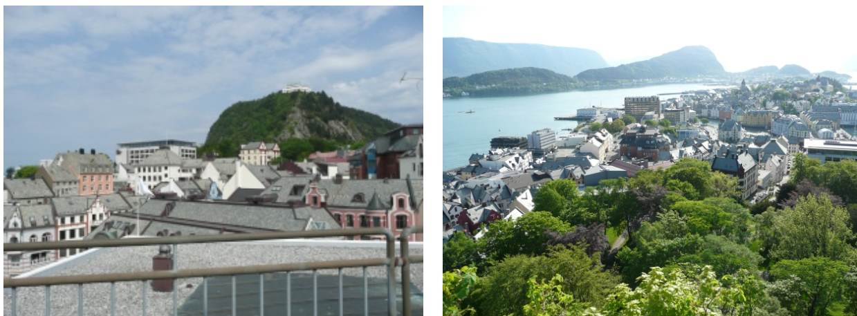
Skifertakene har blitt karakterisert som Ålesunds 5. fasade, og de gjør et imponerende inntrykk når byen betraktes fra noen av de omkransende høydene. De er imidlertid utsatt når huseierne ønsker å utvide med loftsleiligheter. Foto: NIKU.
