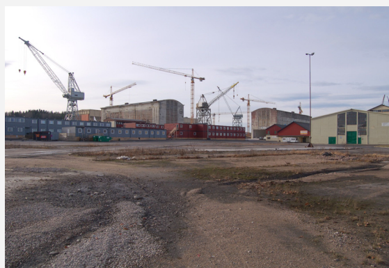
Utsikt mot dokk-området. Kranene og flere av de store hallene dominerer fortsatt området (2008). Foto: NIKU
