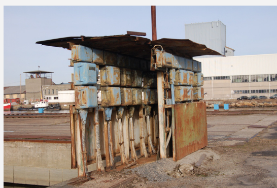
Industriarven på Værste er variert. Her er et eksempel på teknisk installasjon. Foto: NIKU.
