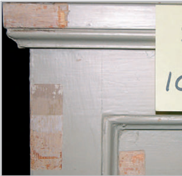
Figur 2: Avdekking på kirkebenken som ses på figur 1. Det eldste malinglaget var lys gulbeige og svært avslitt og skittent. Vi hadde en mistanke om at dette kunne være rester av en eikeådring, men fordi malingen var så nedbrutt var det usikkert om vi tolket funnet korrekt. Foto: K. Solberg, NIKU 2004.
