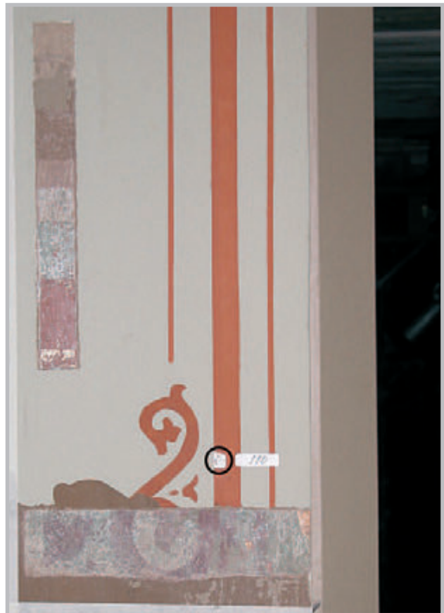
Figur 5: Avdekking på vegg i Slottskapellet. Den senere dekoren var en rekonstruksjon av den opprinnelige dekoren fra slutten av 1840-årene, utført ved en omfattende restaurering av kapellet i 1967. Fargetrappen viser alle de underliggende malinglagene. Nederst ses utydelige rester av opprinnelig limfargedekor. O = uttakssted for tverrsnitt, figur 6. Foto: K. Solberg, NIKU 2004.
