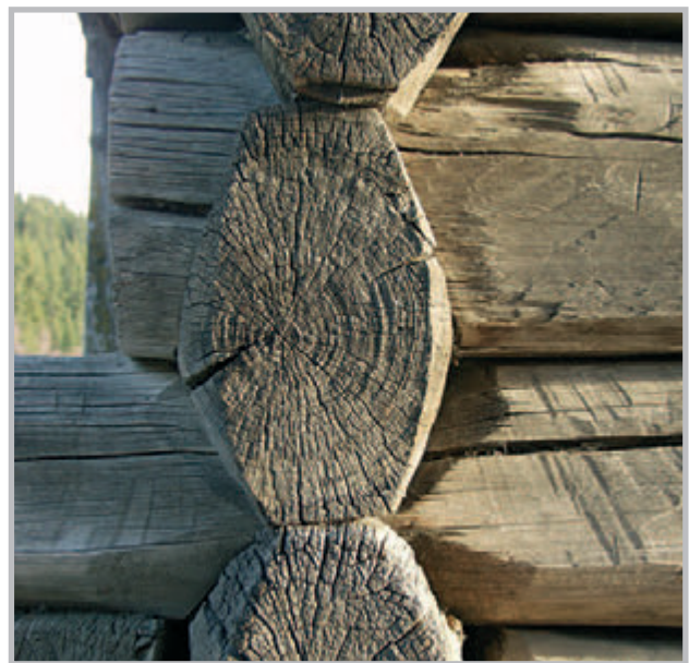
Figur 1. Eksempel på spissovale novhoder. Detalj av stabbur på Thomasgården, gnr. 4, bnr. 6, A1 i Buskerud. Tømmeret er dendrokronologisk datert til 1635-1636. Foto J. M. Stormes, NIKU.
