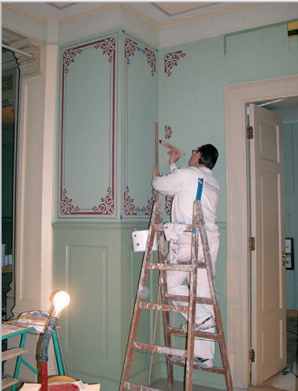
Figur 7: Ved restaureringen av Slottskapellet i 2004 ble veggene igjen dekorert med den opprinnelige strek- og sjablondekoren. Det ble valgt malematerialer og farger som var mer i overensstemmelse med det opprinnelige enn ved restaureringen i 1967. Foto: K. Solberg, NIKU 2004.
