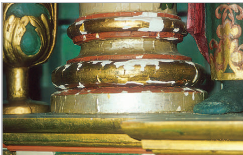
Figur 1. Resultat av skade relatert til klimavariasjoner (Flesberg kirke). Foto T. M. Olstad, Riksantikvaren 1990.
