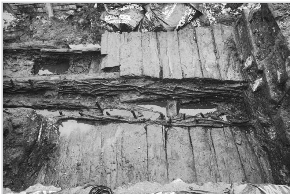
Figur 16: Fra Nedre Langgate, Tønsberg (delfelt "K31-K33"). Bildet viser et passasjeområde med bordlegning på hver side av en åpen renne. Denne rennen representerer en grense mellom bygårder.
