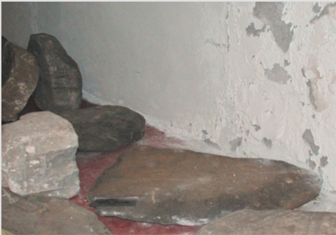
Foto 28 Vedlikeholdet vart vurdert som uakseptabelt i det gamle magasinet ved AmS, der murpuss fell ned på utildekkte gjenstandar som er lagra direkte på golv.
