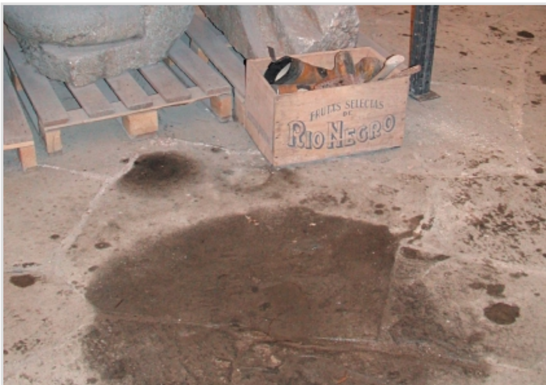
Foto 18 Lekkasjar frá tak i fjermmagasin ved BM-K.
