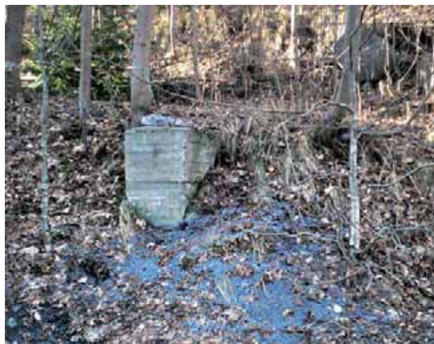
Figur 68. Fundament i forlengelsen av Snekkerverkstedet. Foto NIKU 2006.
