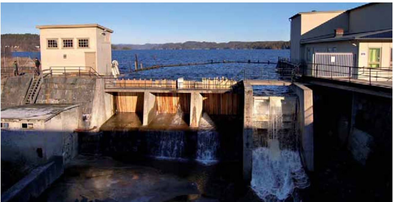
Figur 8. Demning ved Farrisdammen. Foto NIKU 2007.
