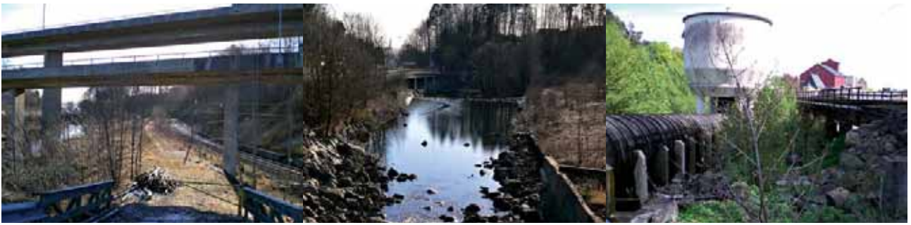
Figur 73a-c. Tekniske anlegg som mulig utgangspunkt for bedre tilgjengelighet til fra Hammerdalen. Foto NIKU 2006-08.
