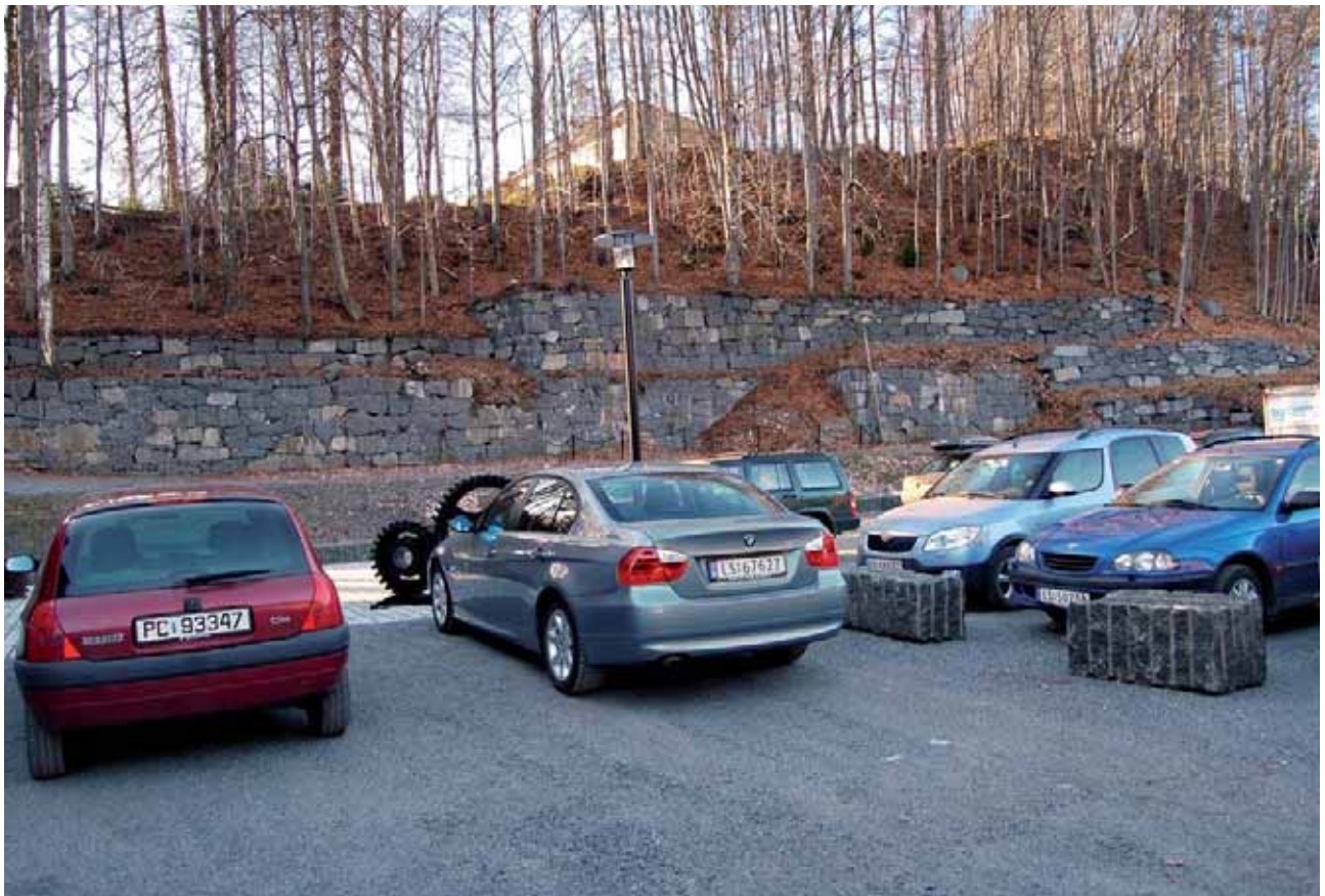
Figur 26. Støttemur bak masovnen fra 1845. Foto NIKU 2008.
