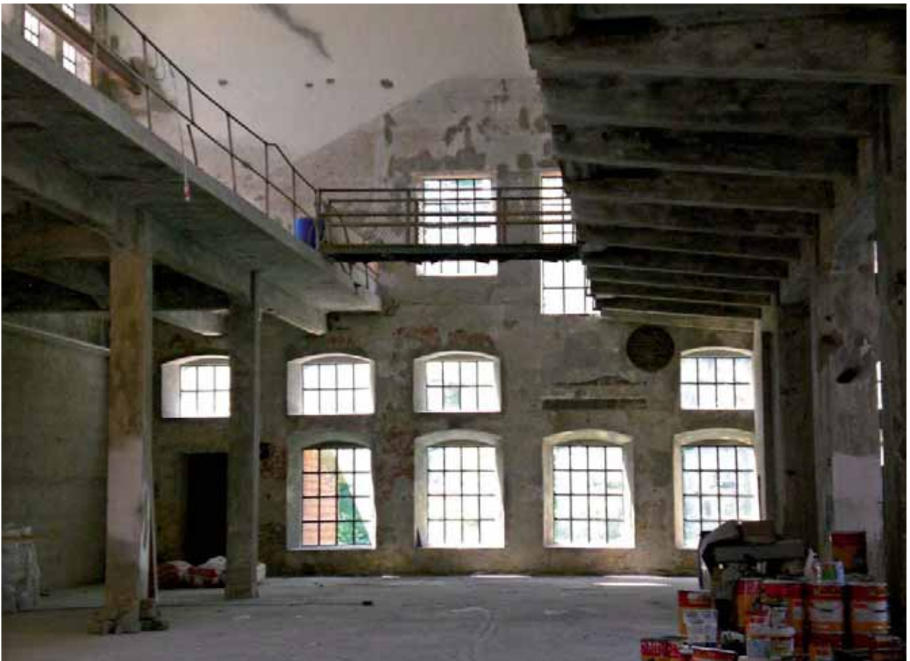
Figur 37. Sliperiet, interiør. Foto NIKU 2007.
