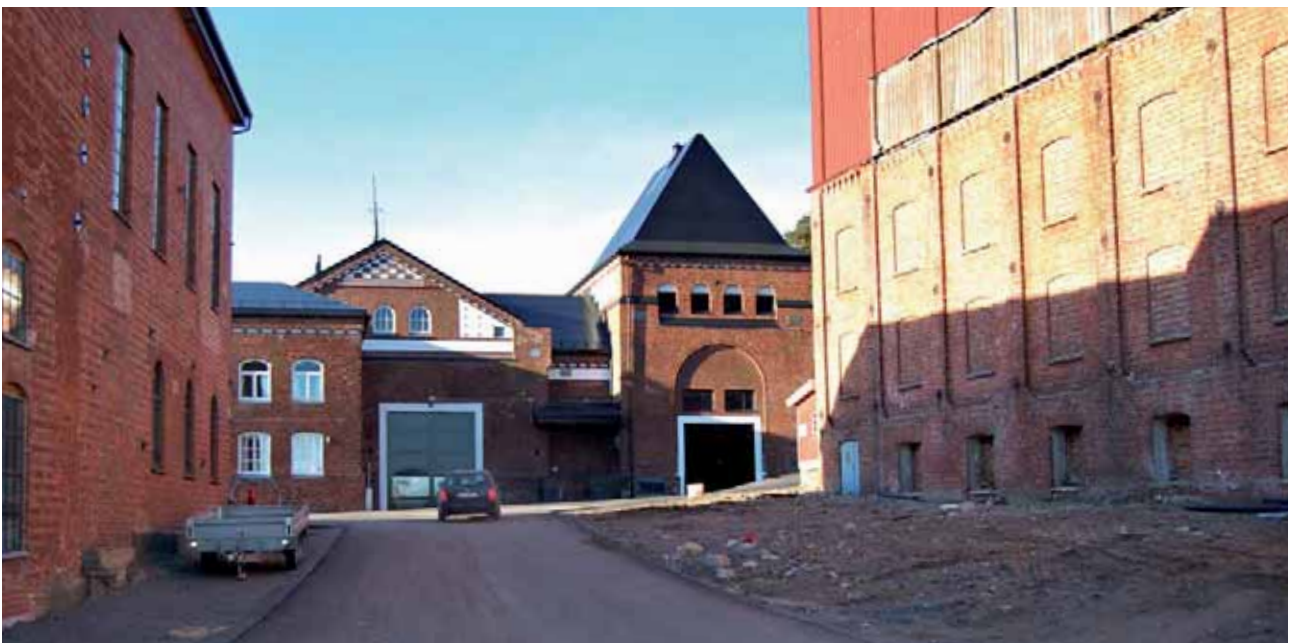
Figur 29a-b. Plassen mellom Mølla og Sliperiet sett mot fjorden (over) og mot Kraftstasjonen (under). Foto NIKU 2007/08.
