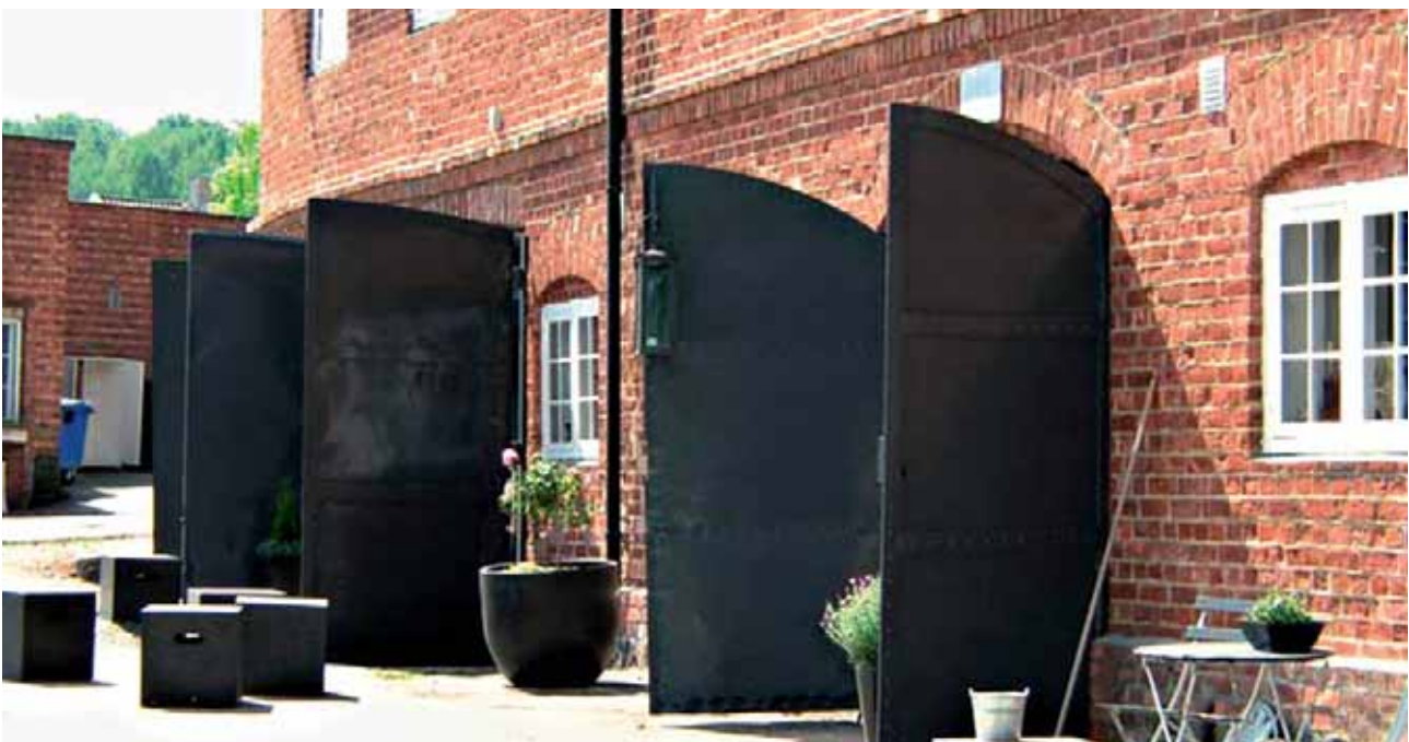
Figur 50. Detalj fra Snekkerverkstedet, med de originale portene i jern, samt smårutete vinduer (foto fra www.eiendom.fritzoe.no ).
