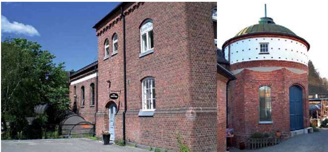
Figur 30a-b. Utsnitt fra Kraftstasjonen. Foto NIKU 2007/08.
