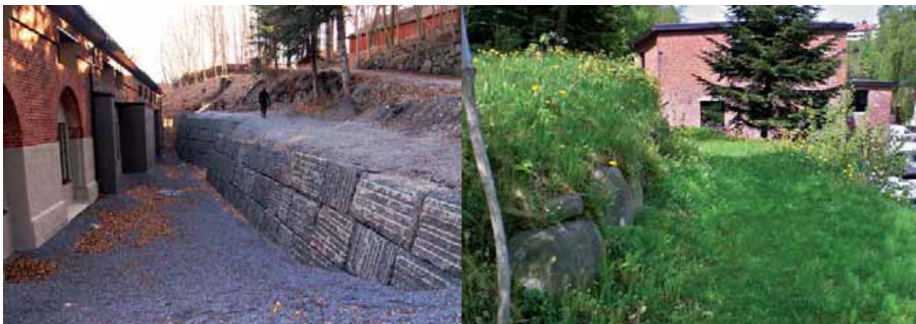
Figur 27a-b. Gjenoppbygget støttemur for den første masovnen bak valseverket og vei inn til masovnen. Foto NIKU 2008.
