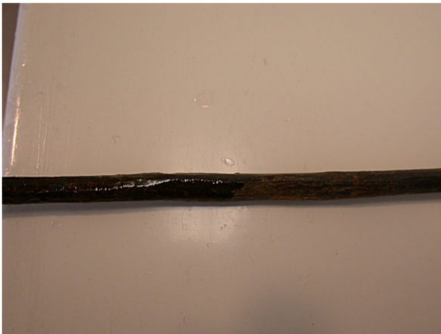
Fig. 14 – Her er nederste del av flaggstangen rensert mekanisk for rust, hvorpå Ferro-bet og Owatrol har blitt påført for å se om det kunne gi et tilfredsstillende resultat. Foto Malou Genfors 2006
