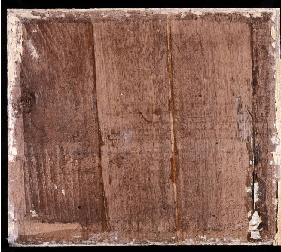
Fig; 5: Korsfestelsen, bakside – helopptak – før behandling, panelene er skråhøvlet ut mot kanten (Foto B. R. Lindstad).
