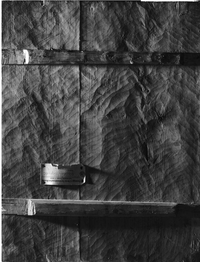
ill. 5. Baksiden av ikon nr. 8 (Anásthatis) i kapellet i Neiden. Teksturen viser spor etter bruk av skavjern. Labankene er tiløkset for å passe inn i en ikonostás. (Merkelappen er påsatt opp-ned.) Foto: Anne Tveit Winterthun 1994.
