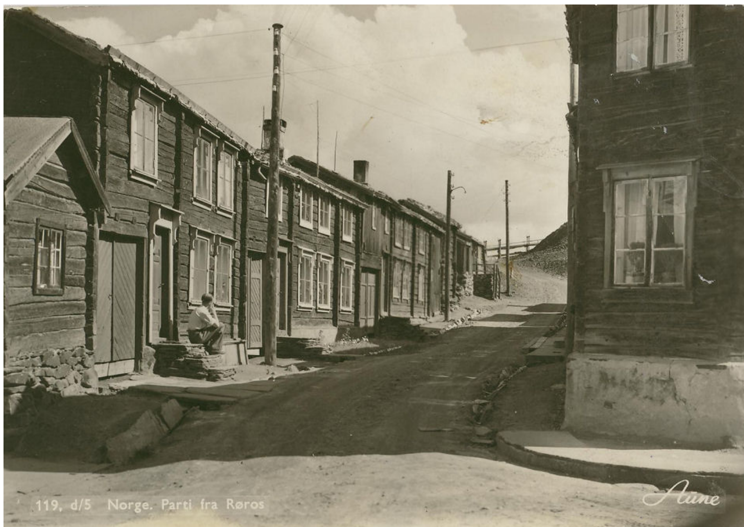
Figur 10. Sleggveien sett fra hjørnet ved Ole Guldahlgate. Postkort datert 4.10.1952. Hele husrekka til venstre og huset på hjørnet til høyre er fredet. Riksantikvarens antikvar har ennå ikke vært og restaurert husrekka. Første og annen generasjons vinduer står ennå på plass. Foto: Aune. Avfot. Jon Brønnes postkortsamling.
