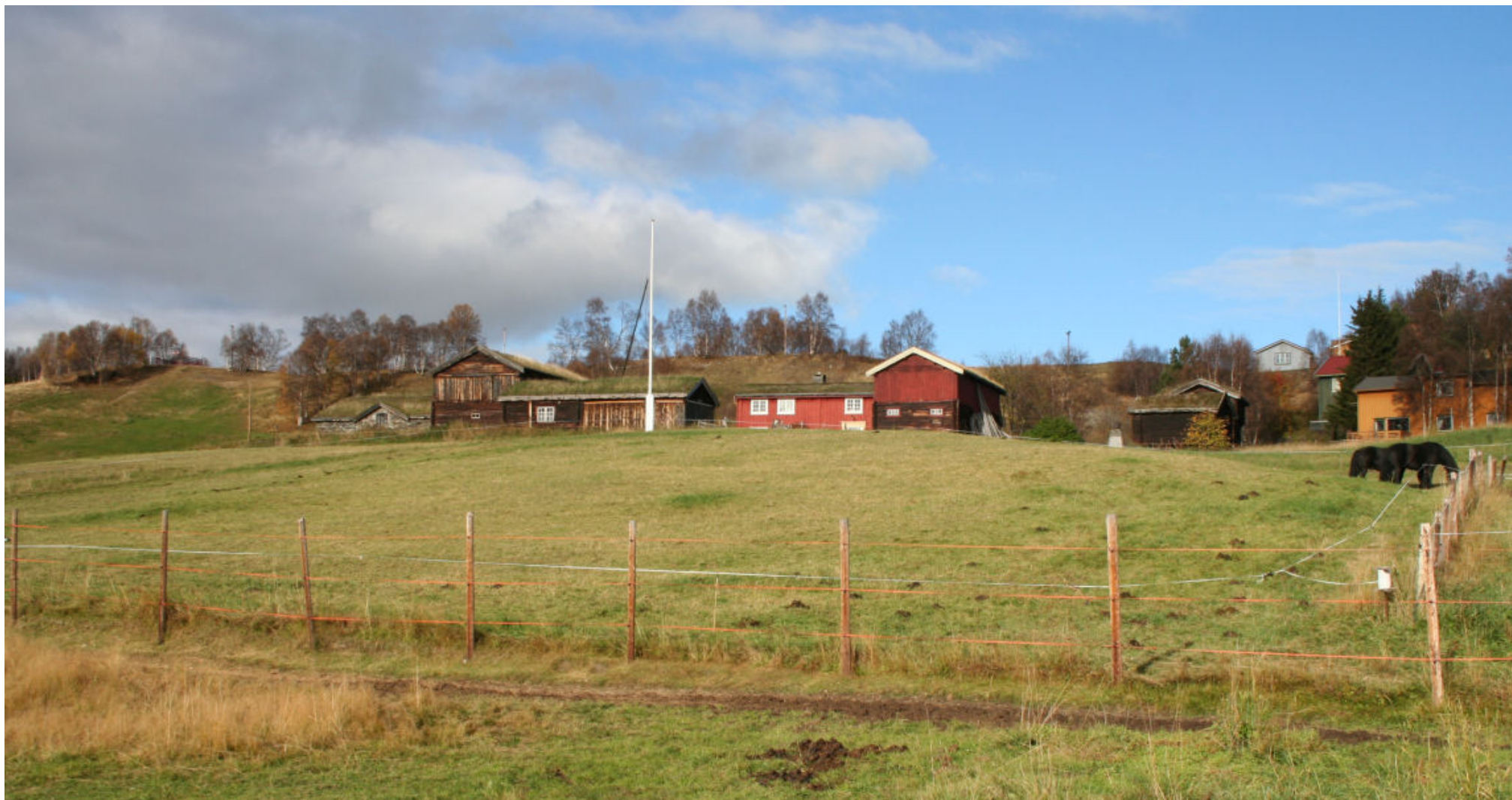
Figur 2. Åsengården er et samlet, nesten lukket tun som ligger fritt og åpent midt i byen, fremdeles omgitt av betemark for dyra. Hovedbygningen gjennomgikk i 1950-åra en kraftig restaurering i regi av Riksantikvaren ved arkitekt Halvor Vreim. Her er gården sett fra "Tufta". Foto: Jon Brønne 2006.
