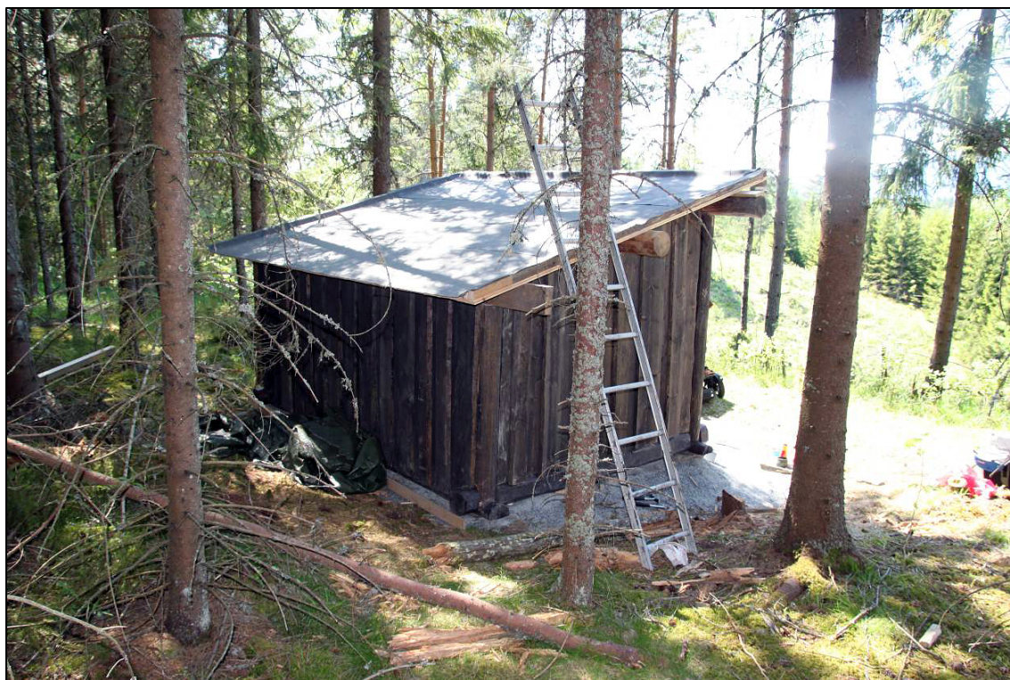
Figur 67 Jønsberg videregående skole bygger gapahuk 25.05.2012. Foto: Hilde R. Amundsen, NIKU.
