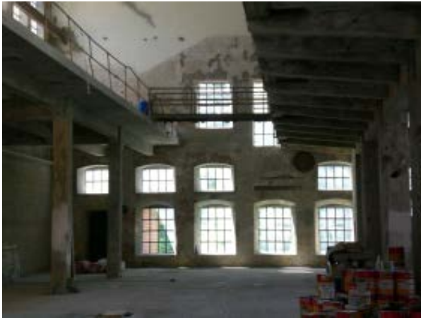
Figur 39 Sliperiet på Hammerdalen i 2008 før rehabiliteringen tok til (NIKU)
