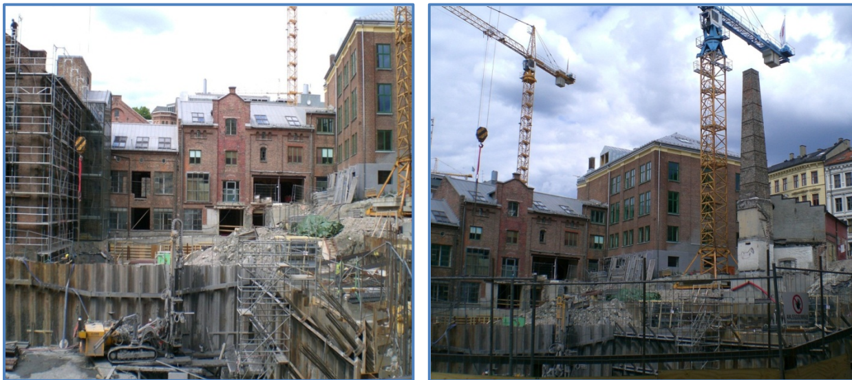
Figur 33 og 34 Fossveien 20-24 under rehabilitering (foto tatt 2010)
