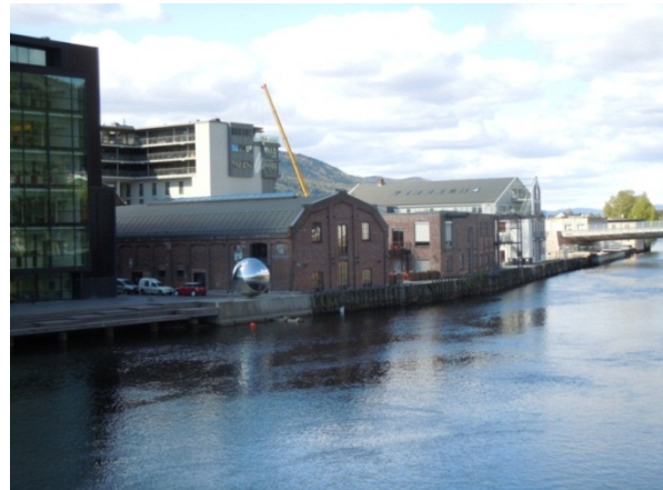
Figur 5 Papirbredden i Drammen sett fra elven. Et utsnitt av nybygget med blant annet bibliotek og Høgscole Buskerud samt Union Scene, tidligere Drammen Paper Mill
