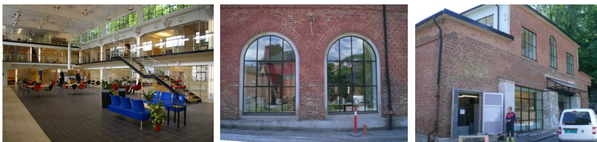
Figur 17 Mekanisk verksted - Mekken - etter rehabilitering og ombygging til kontorer (PV arkitekter (innvendig)/NIKU 2007)
