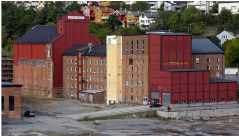
Figur 21 Mølla før riving av det platekleddet bygget lengst sør (Bulken) og ombygging av midtdelen til studenthybler (Fritzøe Eiendom)
