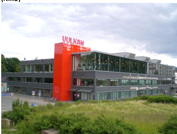
Figur 33 Nye broverkstedet i 2010 (NIKU).
