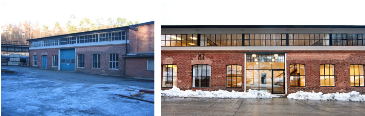
Figur 18 Inngangsparti fra Plateverkstedet før (NIKU 2007) og etter ombygging (Fritzøe Eiendom)
