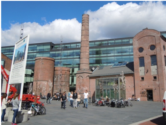
Figur 4 Det gamle fyrhuset, to sedimenteringstanker og Hollenderiet omkranser Papirbredden Torg, med det nye bibliotek- og høgscolebygget i bakgrunnen.
