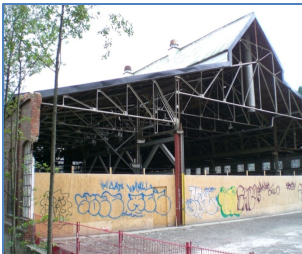
Figur 31 Broverkstedet før ombyggingen, tatt i 2010 (NIKU)
