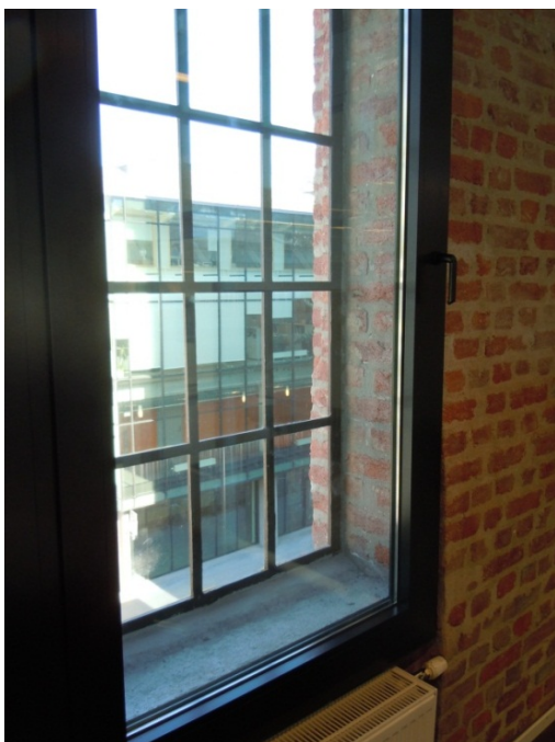
Figur 7 Detalj av restaurert vindu i Hollenderiet, tatt fra innsiden.
