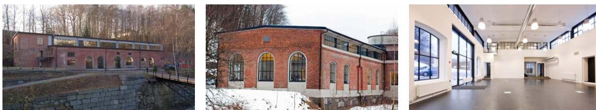
Figur 11 Mekanisk verksted og Plateverkstedet (utvendig og inne) etter ombygging til kontorer (Fritzøe Eiendom)
