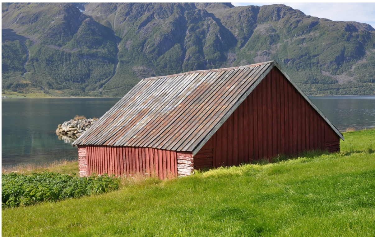
19023301003: Denne bygningen er kategorisert som naust, sjøhus fyr m.m., og samfunnssektoren er landbruk/fiske/fangst. Sosial miljøsammenheng er bonde, og som 46 % av de undersøkte bygningene i Tromsø i 3. omdrev ligger dette naustet i spredtbygde strøk, nærmere bestemt i Sørfjorden. Foto: AS, NIKU 2011.
