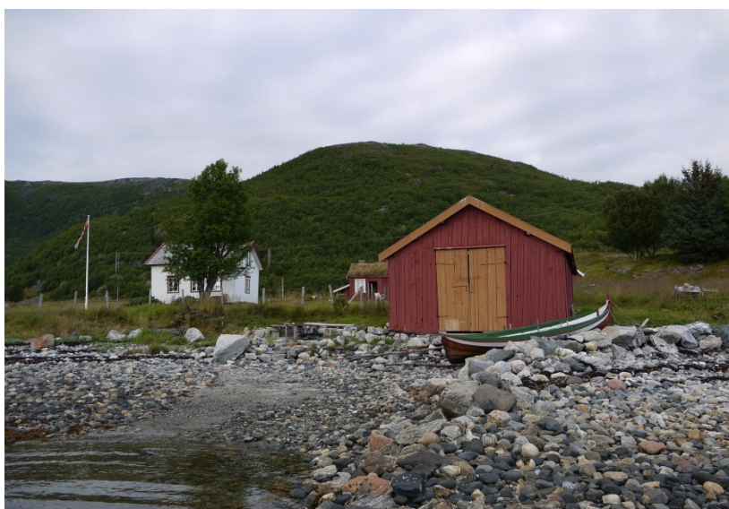
19024102015: Buvika ligger sør-vest på Kvaløya i området Hillesøy, hvor 9 % av de undersøkte bygningene i 3. omdrev ligger. Dette er området med den høyeste tapsandelen i kommunen i 3. omdrev (10 %). Foto: ÅD, NIKU 2011.
