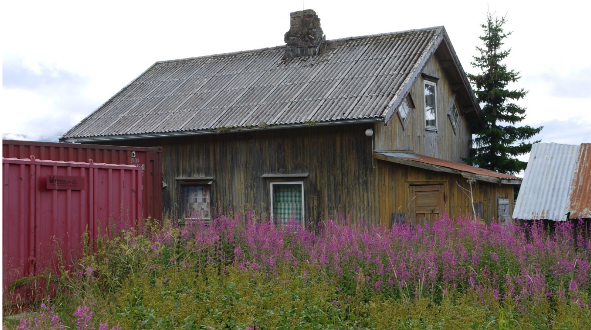
19021502009: I forbindelse med kontrollregistreringen i 3. omdrev sto bygningene fremdeles tomme. Forfallet var kommet lenger, og bygningene ble registrert som sterkt truet. Foto: ÅD, NIKU 2011.
