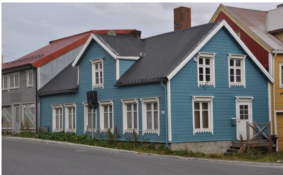
19020103036: Områdene som omfattes av sentrumsplanen har lavest andel tapte og sterkt truede bygninger i Tromsø i 3. omdrev, men det er i dette området det er høyest andel av endrete bygninger. Denne bygningen i Storgata er tilbakeført til eldre uttrykk og er registrert med C-liten endring. Foto: AS, NIKU 2011.
