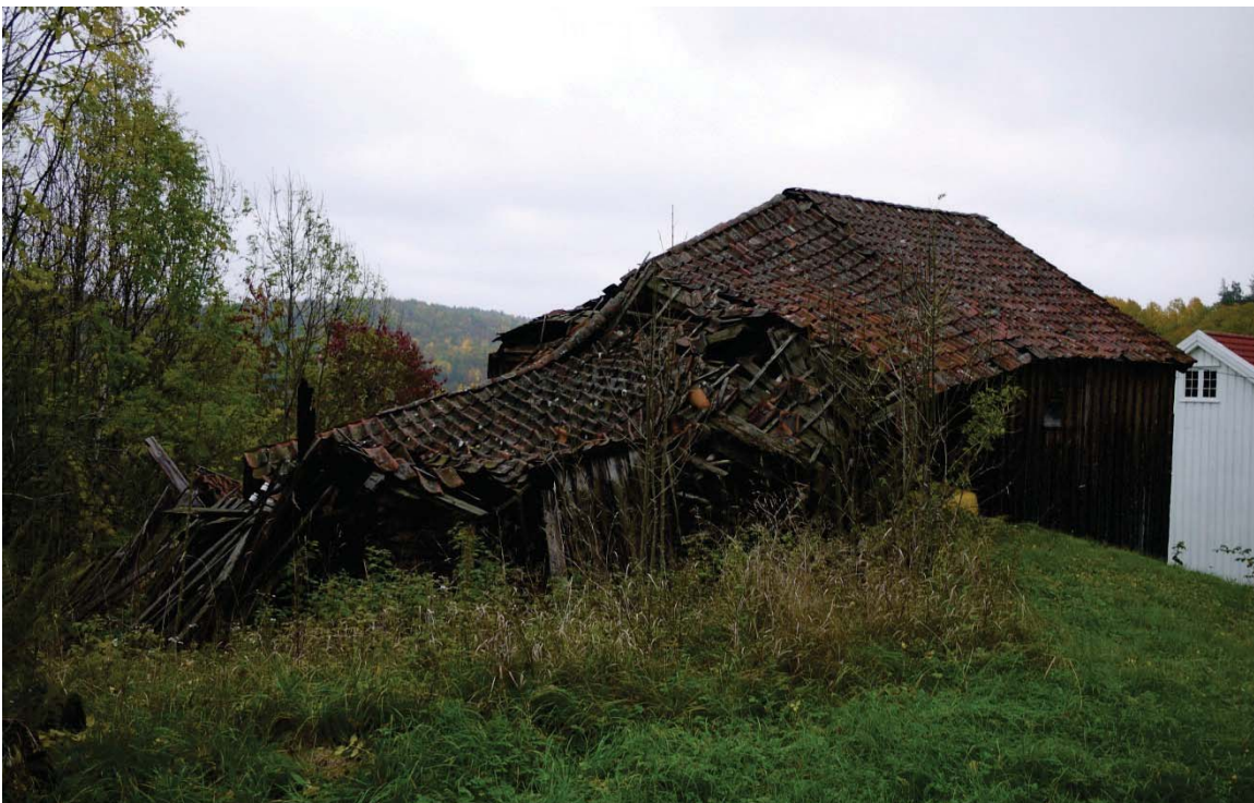
09110104082: Vanligste tapsårsak er gradvis forfall av bygninger som ikke lenger er i bruk. Noen av bygningene blir revet, mens andre faller i ruin.
