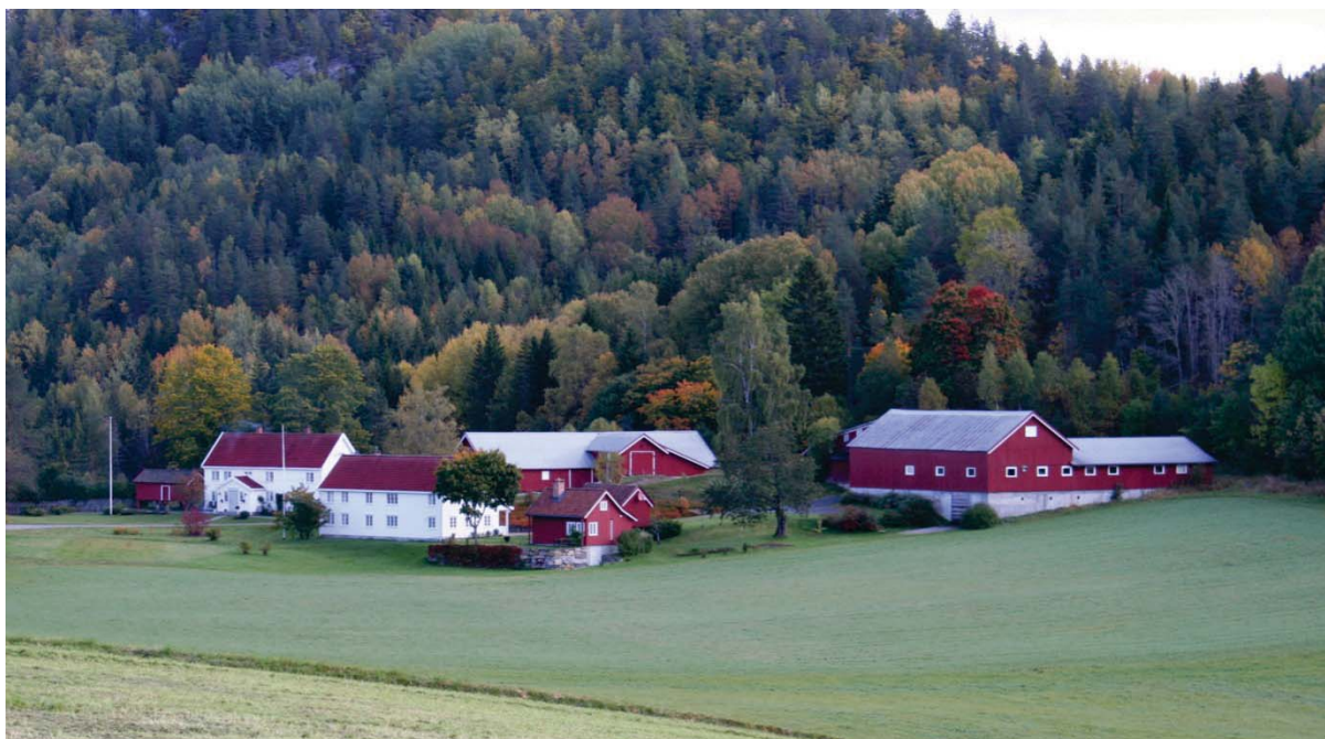
09110106036,035,039,037,038,040: I 3. omdrev er 56 % av de gjenstående bygningene i Gjerstad uendret og intakt. På denne gården på Sundebru er det bare driftsbygningen til høyre og det minste våningshuset som er endret.
