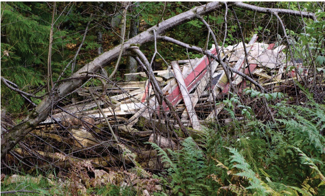
09110204018: I 2010 var bygningen gått tapt.
