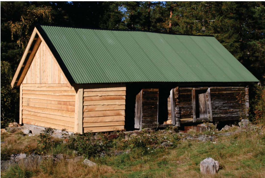
09110207041: Ny takteking og veggkledning gir laveste endringsgrad (C-endring).
