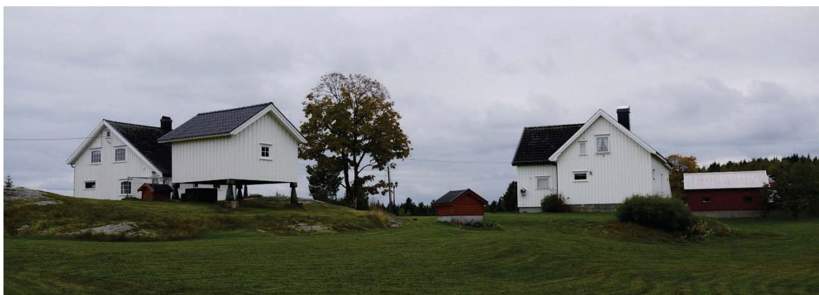
09110101033: Bygningstilstanden er gjennomsnittlig bedre i spredtbygde enn i tettbygde strøk i Gjerstad i 3. omdrev.
