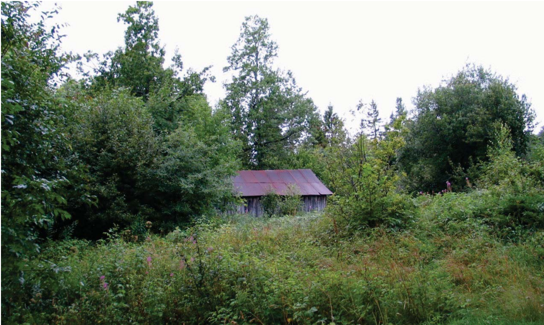
09110204018: Tapsprosenten for utmarkshusene ligger over det gjennomsnittlige tapet i Gjerstad. I 3. omdrev utgjør denne bygningsgruppen kun en tiendedel av bygningene. Dette sommerfjøset ble registrert som truet i 2005. Foto: Kulturminnekompaniet 2005.
