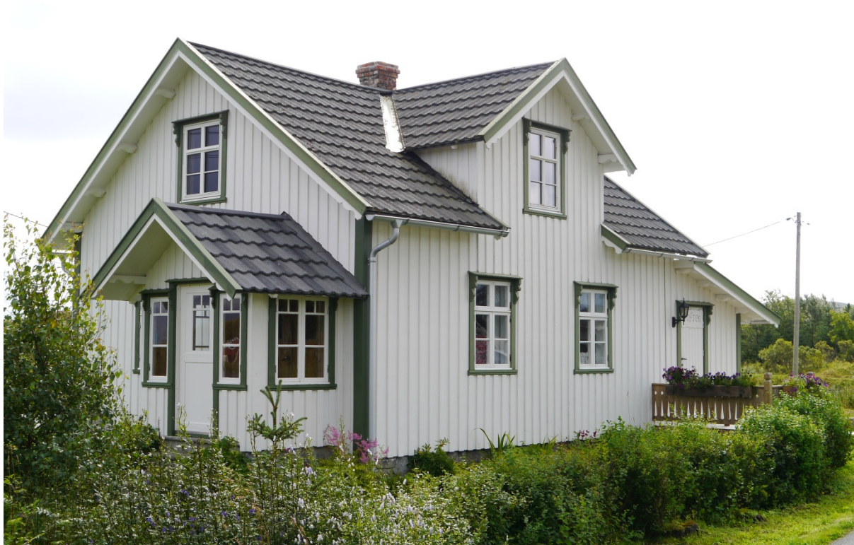
18150103016: Endring av bygningens overflater, for eksempel ved utskifting av panel, takbelegg, vinduer eller listverk, registreres som C-endring. Foto: KF/NIKU 2013
