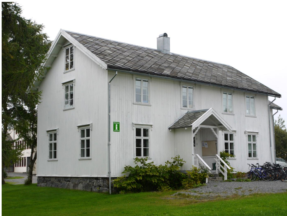
18150106027: I Vega kommune har kontrollregistrering av SERFAK-bygninger blitt gjennomført i 2003, 2008 og 2013. Den gamle skolebygningen på Gladstad er registrert som uendret og intakt gjennom alle tre omdrevene. Foto: ÅD/NIKU 2013
