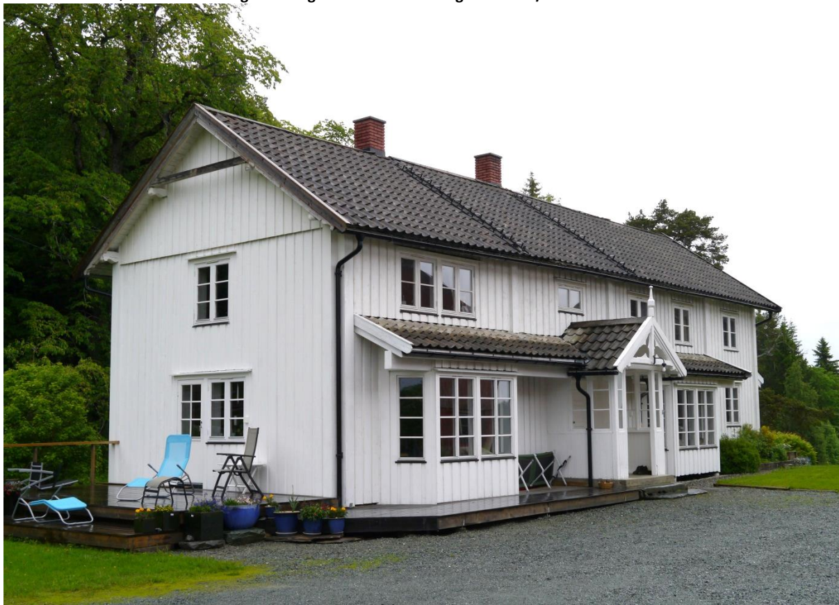
16530025011: Mindre volumendringer, for eksempel et påbygd inngangsparti, registreres som B-endring. Foto: ÅD/NIKU 2013
