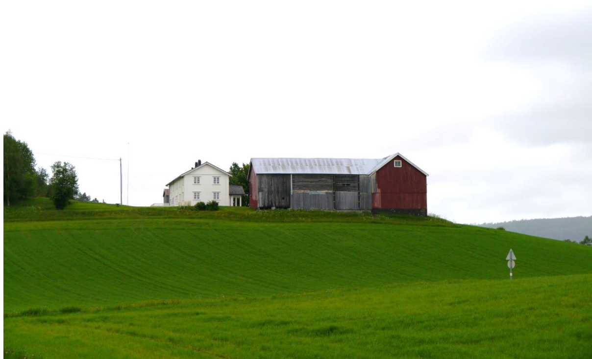
16530025028: I 3. omdrev er tapsandelen for SEFRAK-bygninger lavere i spredtbygde enn i tettbygde strøk av Melhus kommune. I 1. omdrev var det omvendt og i 2. omdrev var bygningstapet jevnt fordelt. Foto: ÅD/NIKU 2013
