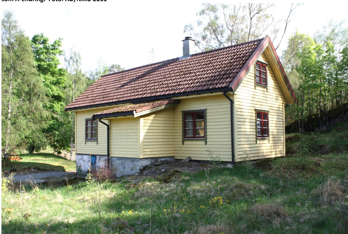
14010109004: Mindre volumendringer, for eksempel et tilbygd inngangsparti, registreres som B-endering. Foto: RM/NIKU 2013
