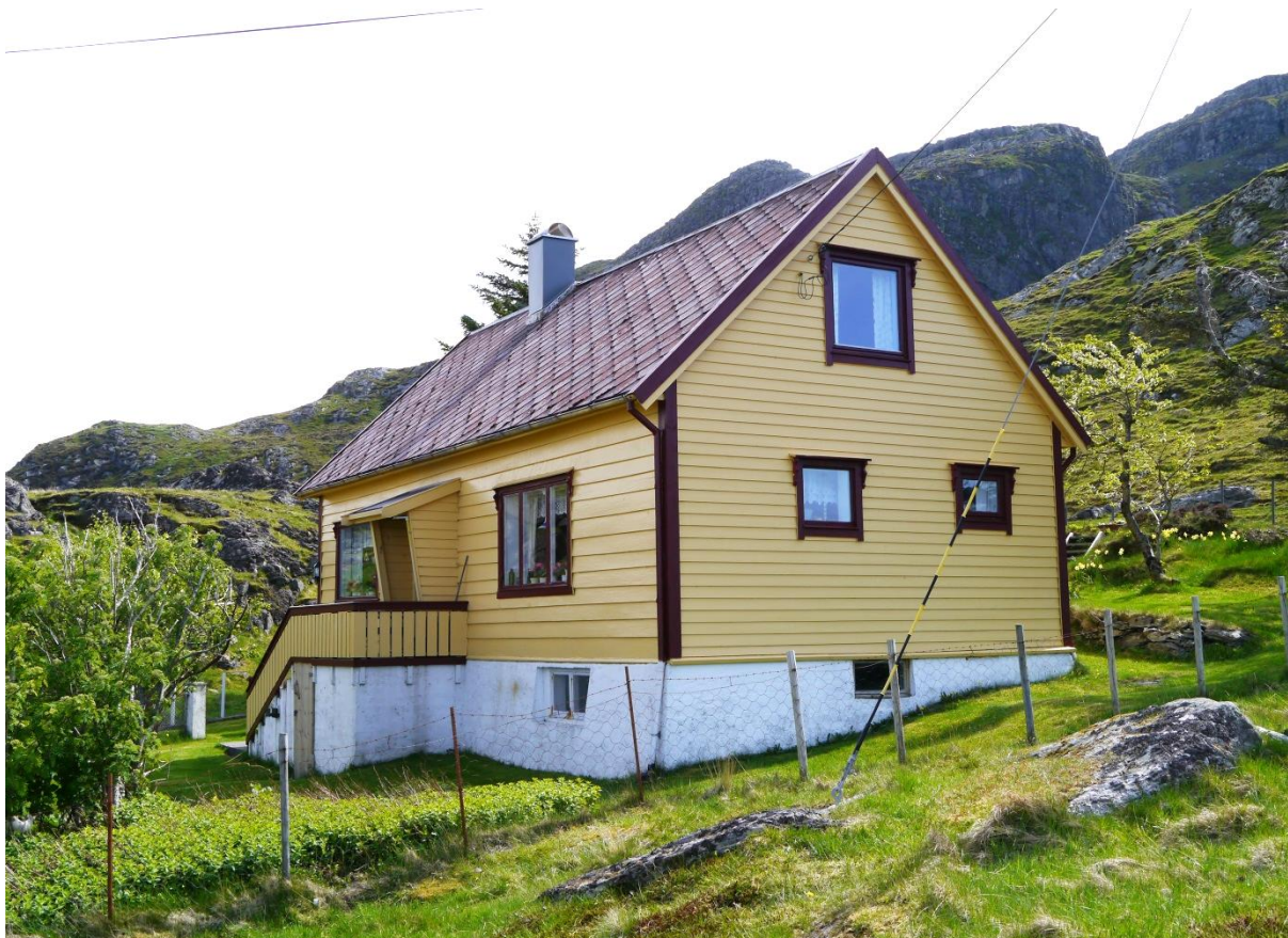
14010204060: Endring av bygningens overflater, som utskifting av panel, takbelegg, vinduer eller listverk, registreres som C-endring. Foto: ÅD/NIKU 2013
