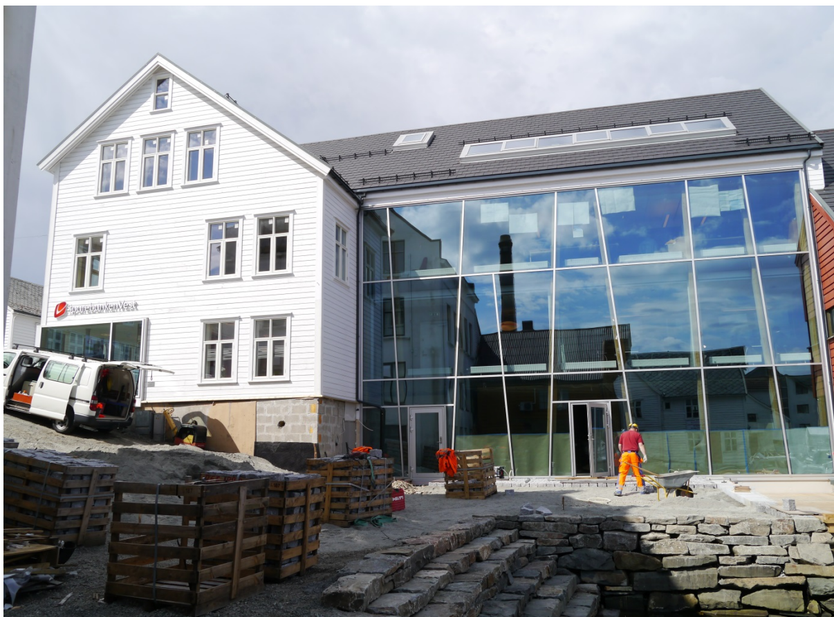
14010301010: Større volumendringer, slik som tilbygget på denne bygården i Strandgata i Florø sentrum, blir registrert som A-endering. Foto: ÅD/NIKU 2013
