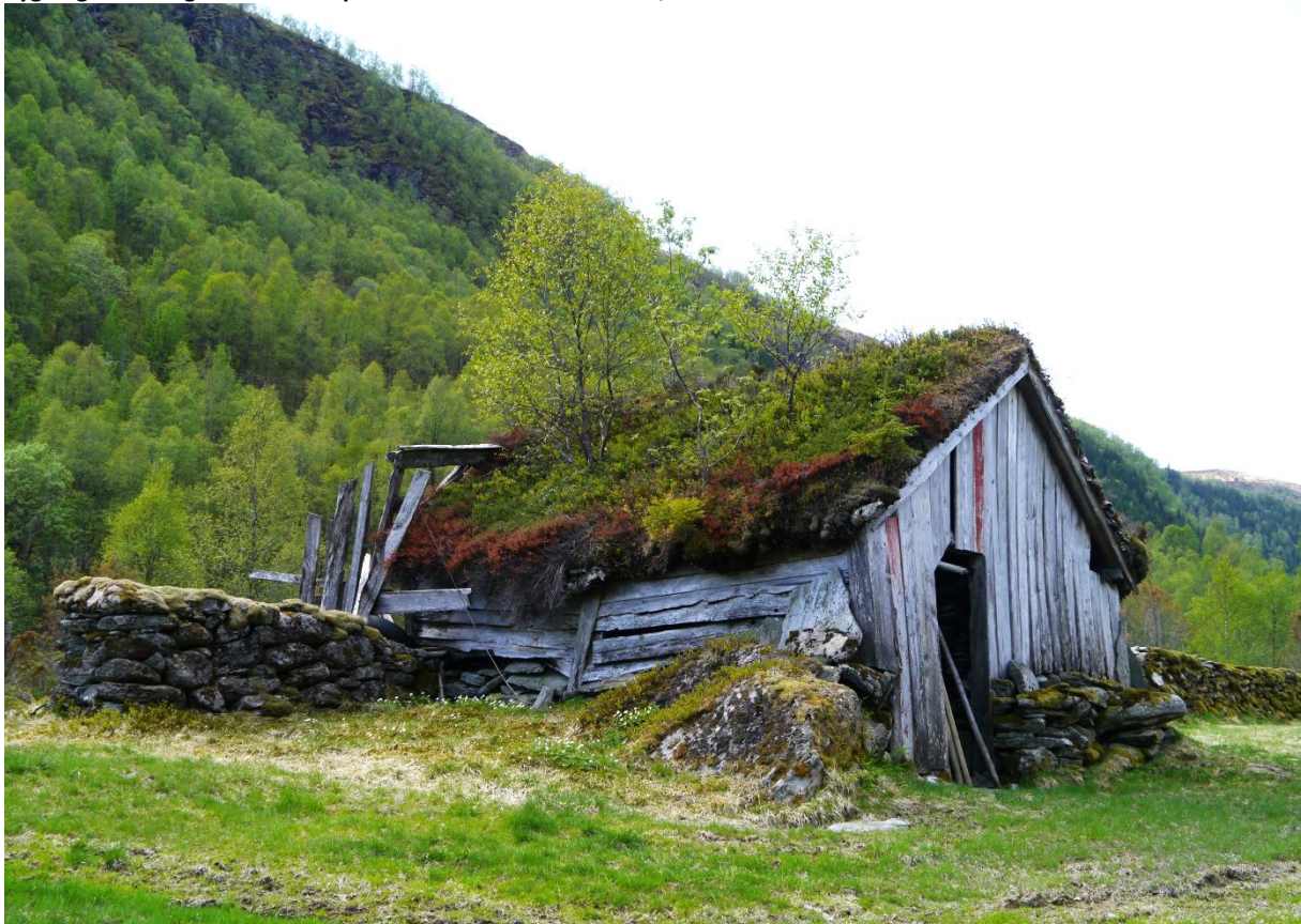
14010103020: De SEFRAK-registrerte utmarkshusene er bygningskategorien med høyest tapsandel i Flora kommune i 3. omdrev. Foto: ÅD/NIKU 2013
