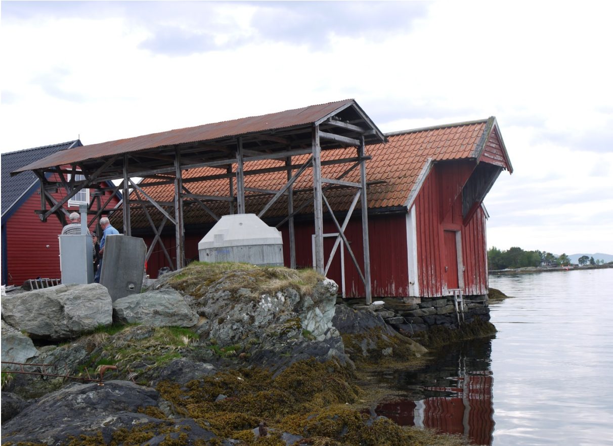
14010106042: 120 SEFRAK-registrerte naust og sjøhus eldre enn 1900 er registrert i Flora kommune i 3. omdrev. Ingen har store volumendringer og den bygningstekniske tilstanden i denne bygningskategorien er noe bedre enn gjennomsnittet for kommunen i sin helhet. Foto: LM/NIKU 2013
