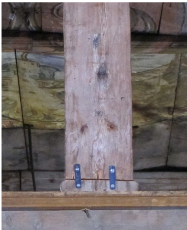
III. 21. Montering av endekapitel til korsstamme på baksiden av krusifikset. Foto: NIKU 2011.
