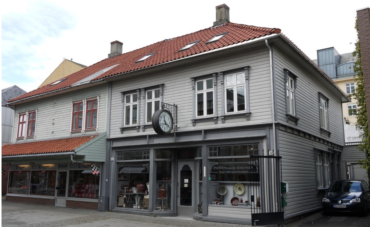
11020001114: Flere av SEFRAK-bygningene i Sandnes sentrum er tilbakeført til eldre uttrykk, blant annet i Langgata og Norestraen, som er to av de historiske sonene som er beskrevet i kulturminneplanen. Et eksempel er fasadene i Langgata 44 og 46, hvor de tidligere husmorvinduene er erstattet med høye, parstilte krysspostvinduer. Foto: ÅD, NIKU 2012.
