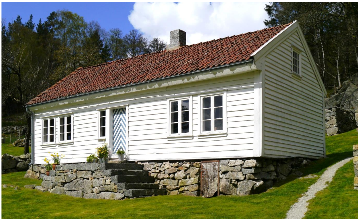
11020030049: 37 % av SEFRAK-bygningene i Sandnes kommune er registrert med C-endringer, det vil si endringer av bygningens overflate, ved utskifting av ytre bygningselementer, som ny panel, takbelegg og vinduer/listverk. Dette våningshuset i Lauvås krets er istandsatt uten volumendringer og er registrert med C-endring. Foto: FC, NIKU 2012.
