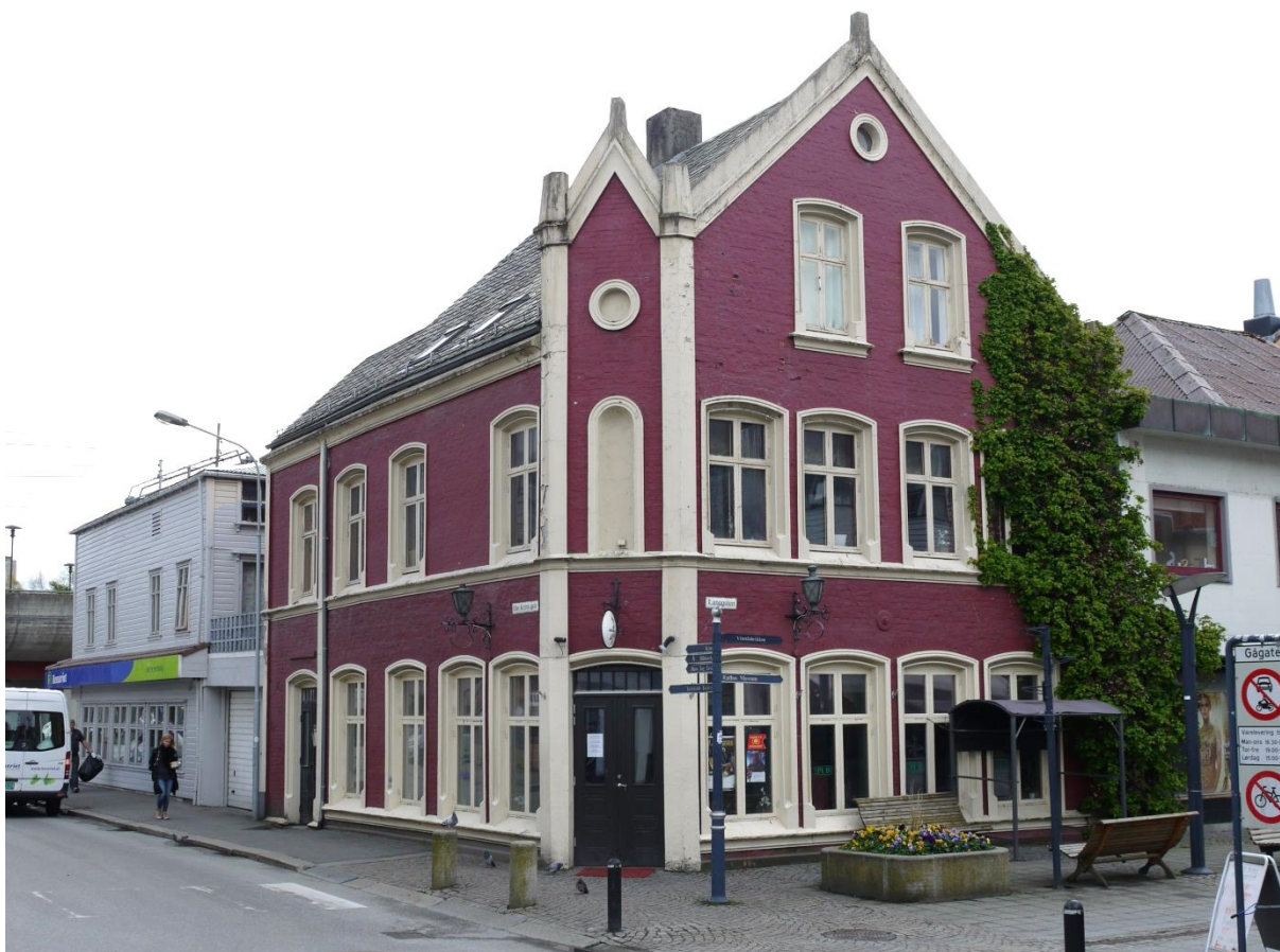
11020001109: 33 av de endrete SEFRAK-bygningene i Sandnes kommune er registrert som tilbakeført til eldre uttrykk. 19 av disse bygningene ligger i Sandnes sentrum, slik som denne forretningsgården i Olav Kyrres gate 2, hvor de store butikkvinduene i første etasje er skiftet ut med vinduer i samme stil som i de øvre etasjene. Foto: ÅD, NIKU 2012.
