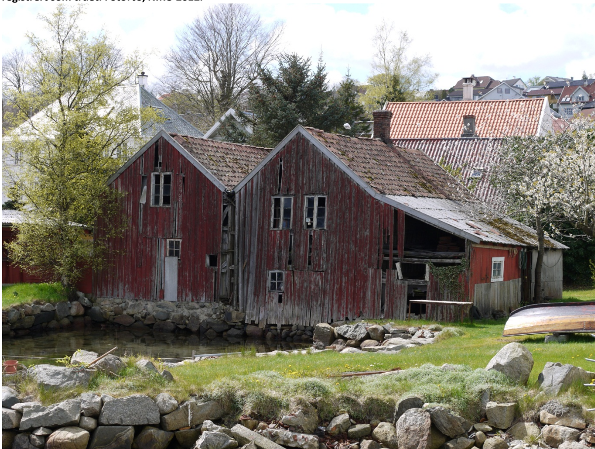
11020001069,070: Tap av opprinnelig funksjon kan være årsak til forfall. Dette gjelder særlig når bygningene tidligere har hatt tilknytning til næringsvirksomhet som ikke lenger er aktuell, slik som de eldre sjøhusene. Foto: ÅD, NIKU 2012.
