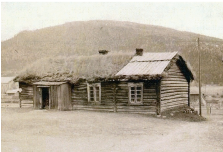
Olen, Alvdal kommune i Hedmark, 1935. Foto av våningshus med torvtak som var blitt utbedret med bord. Norsk Folkemuseum.
