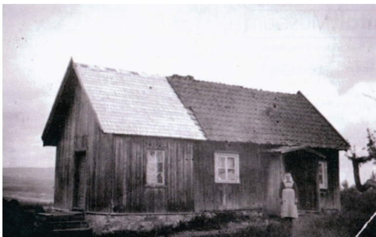
«Glassmesterstuen», 1905-10, Ringsaker kommune i Hedmark. Foto av våningshus med både flis og takstein. Hedmarksmuseet.
