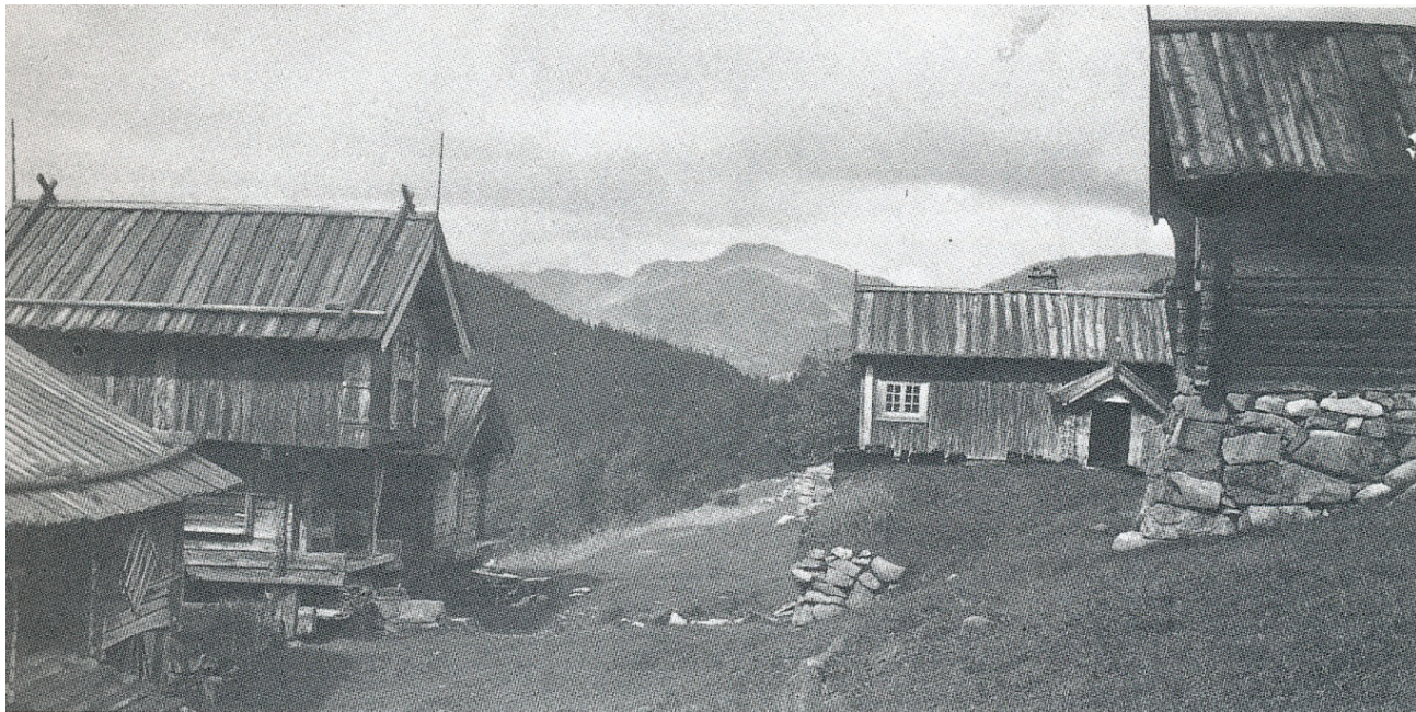
Åkre, Hjartdal kommune i Telemark, ca. 1900. Fotografiet viser to våningshus og tre uthus som alle er tekket med bord. På et par av uthusene er det lagt en grime som holder bordtaket på plass.
