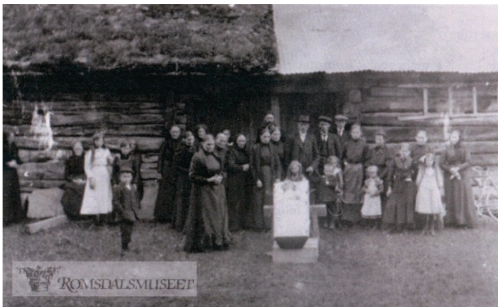
Sæter, Nesset kommune i Møre og Romsdal, ca. 1914. Deler av torvtaket er utbedret med bølgeblikk. Romsdalsmuseet
