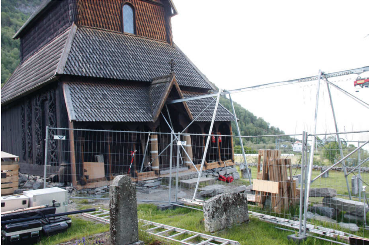
Figur 4 - Rigg for fundamenteringsstein. Foto: Knut Paasche, NIKU.
