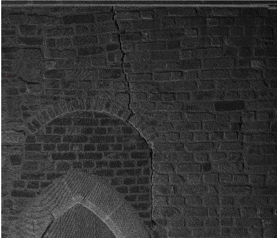
Figur 9 - Utsnitt av punktsky fra østfløyens vestvendte fasade. Bildet viser en vertikalsprekk som løper fra sørsiden av buen mot bunnen av 1800-tallsbygget.
