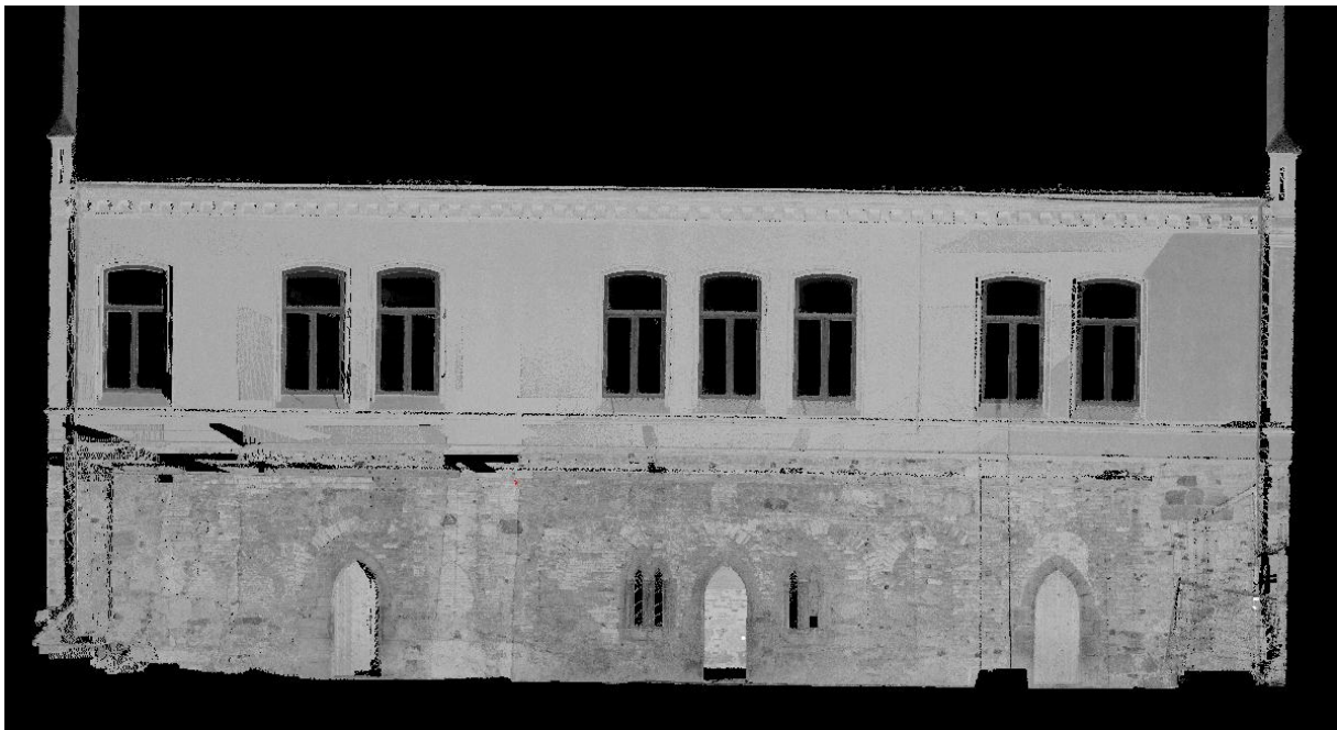
Figur 8 - Punktsky fra vestfasaden. Deler av denne punktskyen ble benyttet til uttegning av området med den vertikale sprekk. Utsnittet er laget i RiSCAN PRO ® og viser punkter med forskjellig refleksjonsstyrke.
