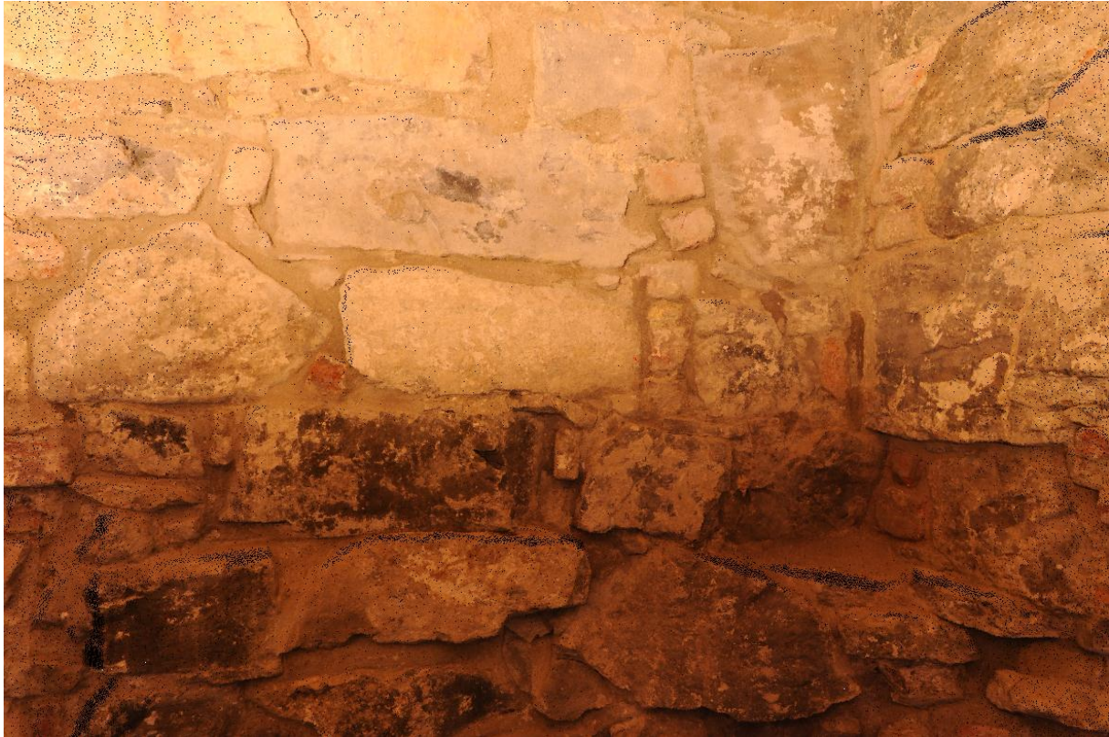
Figur 7 - Utsnitt av punktsky fra kjellerrom. Punktskyen er fargelagt med RGB-farger fra kameraet.
