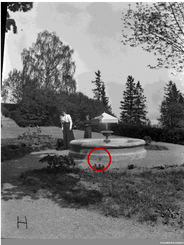
Figur 16 - Fotografi av den øverste hageterrassen med fontene (ca. 1885-90), sett mot nordøst. Igjen kan stoppekranen i nedre del av fontenekaret observeres. Kilde: Stiftelsen Domkirkeodden.
