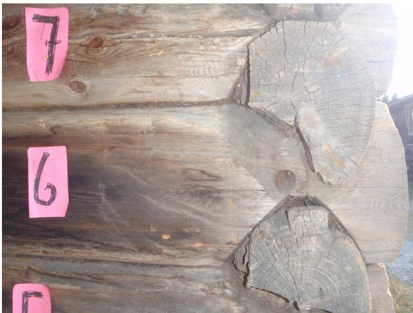
Fig 25.4 Stua på Finstadhaugen i Løten. Naverhull som kan ha med håndtering av stokk under lafting. Tømmer felt vinterhalvåret 1585-1586. Foto: Jan M. Stornes, NIKU
