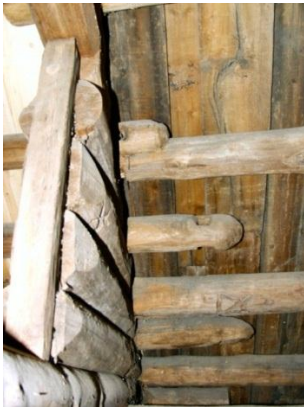
Fig. 20.4 Åser som er øyet med øks. Østre sjøbod i Drammen. Tømmeret felt vinterhalvåret 1695-1696. Foto: Jan Michael Stornes, NIKU
