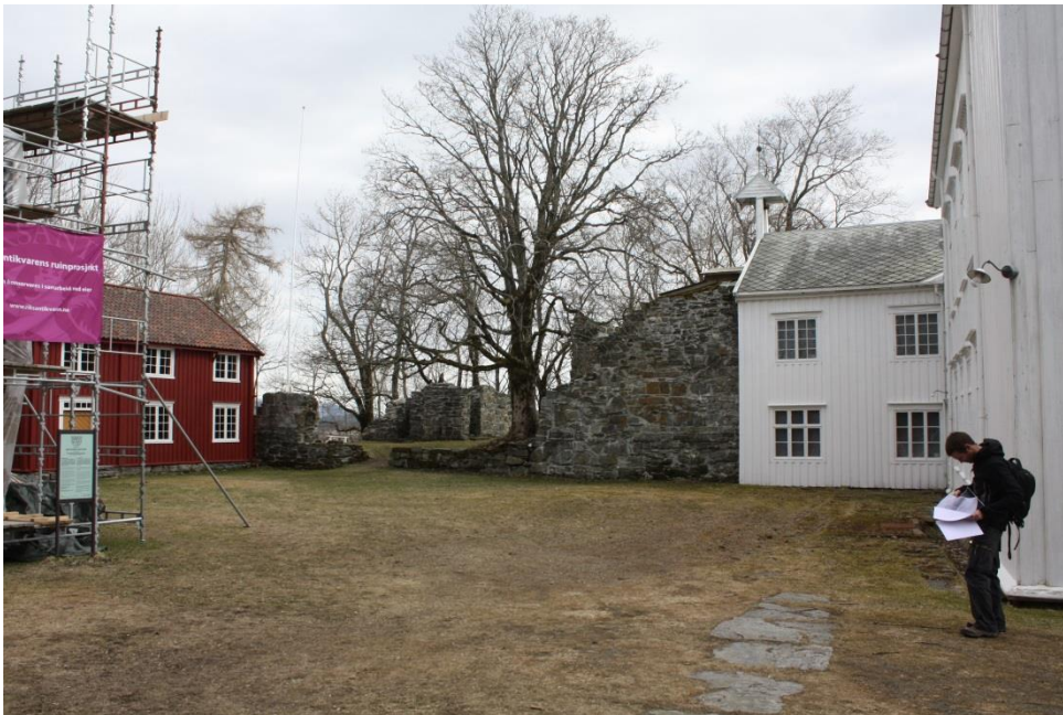
Fig.3 Foto over gårdsplassen på Reins kloster. Plassen avgrenses av ruiner og stående bygninger. Murverket midt på fotoet viser vestveggen i tverrskipet. Til høyre sees hvordan østfløyen fra 1600-tallet er bygget i forlengelse av den søndre tverrskipsarmen. Til venstre sees vestveggen i kirken som var under konservering da fotoet ble tatt. Det røde huset står mer eller mindre på stedet hvor nordmuren i skipet har gått. Foto tatt 06.05.13 mot nordvest.
