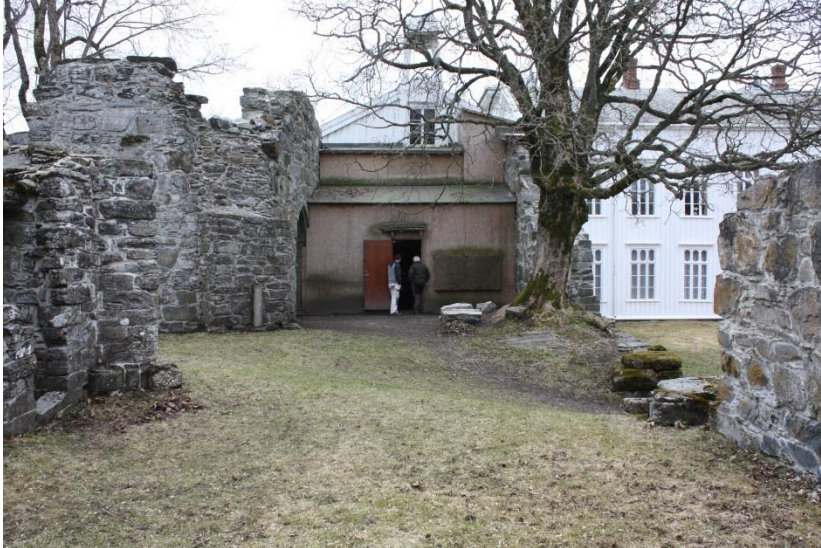
Fig.16 Felt D ligger i ruinen etter tverrskipet og avgrenses av murlevningene. Foto tatt mot sør hvor sørportalen er dekt til i forbindelse med pågående konservering. Foto tatt 06.05.13 av RM.
