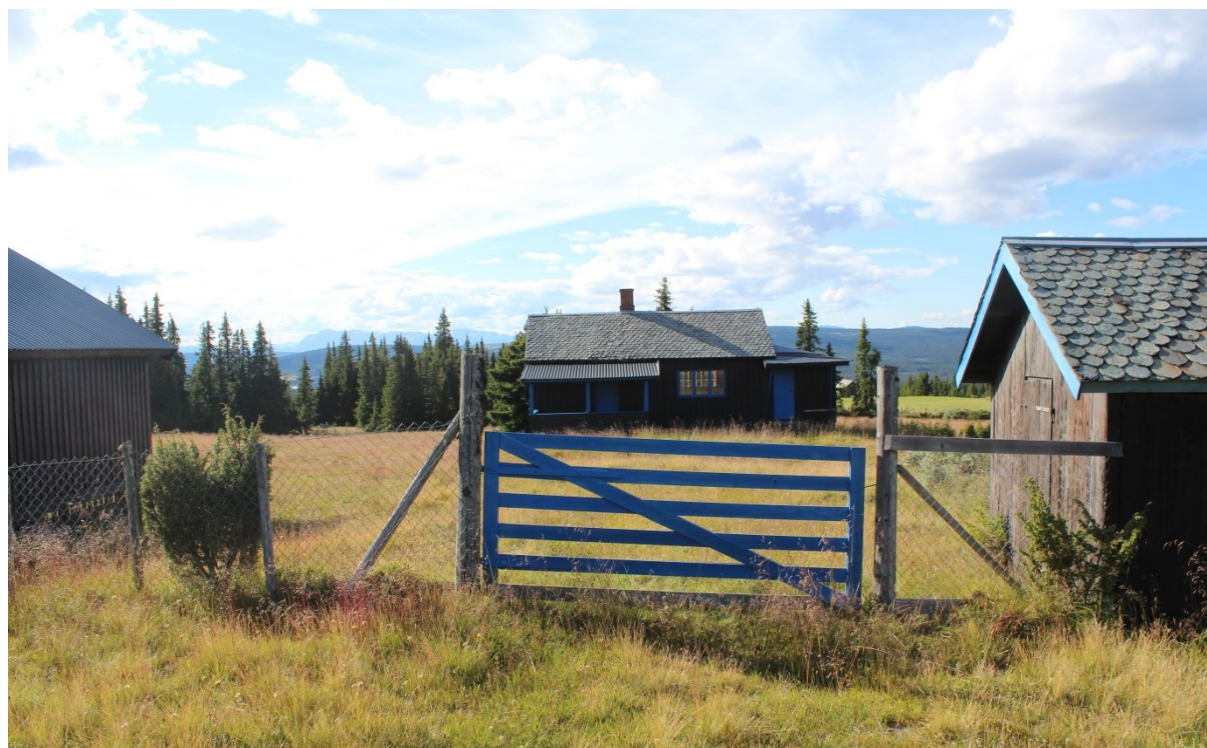
3 % av utmarksbygningene i Nord-Aurdal var tapt i 4. omdrev og 24 % var truet/sterkt truet. De 392 gjenstående utgjør 38 % av SEFRAK-bygningene i kommunen. Foto: RM/NIKU 2015 (05420022182)
