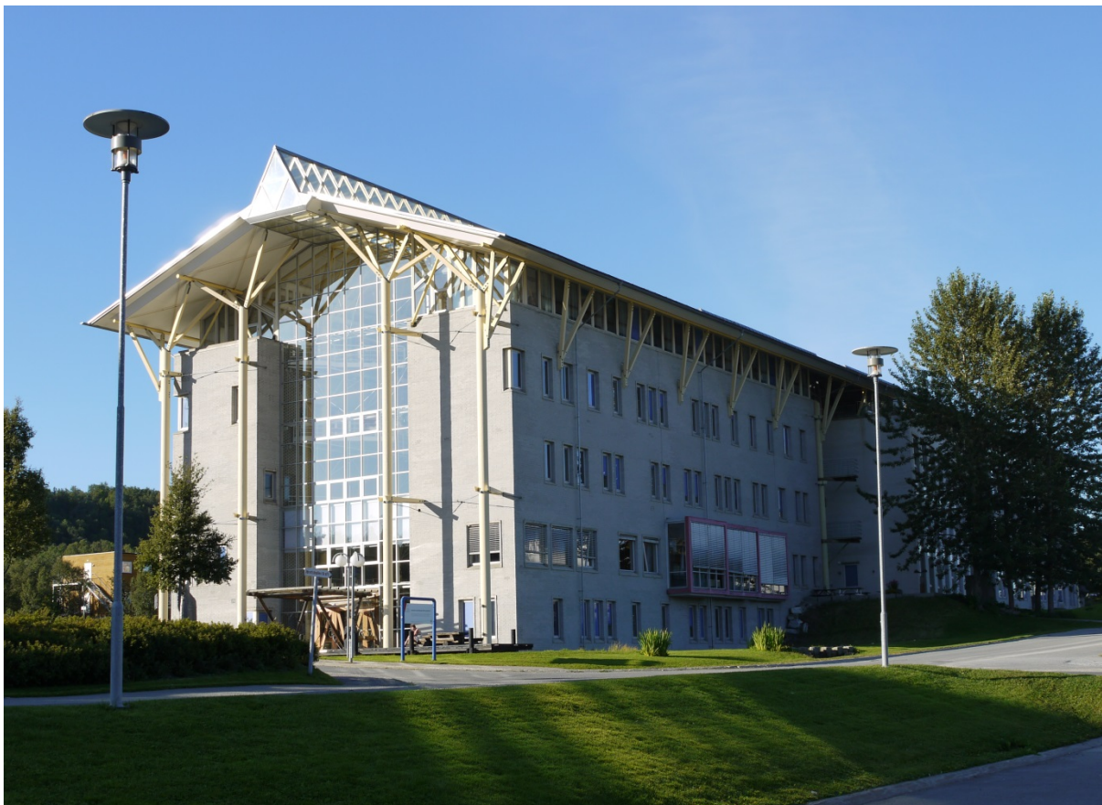
Fiskerihøyskolen er en av 13 statlig listeførte bygninger verneklasse 2 som er kontrollregistrert i Tromsø i 2016. Alle ble registrert med god tilstand. Foto (16528188): ÅD/NIKU 2016
