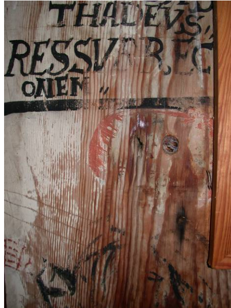
Detalj øst for vinduet
