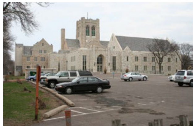
Figur 9. Bethlehem kirke i Minneapolis er utvidet med store bygningsvolumer for møter og undervisning og med ny hovedinngang på siden ut mot den store parkeringsplassen. Foto: J. Chr. Eldal, NIKU 2007.
