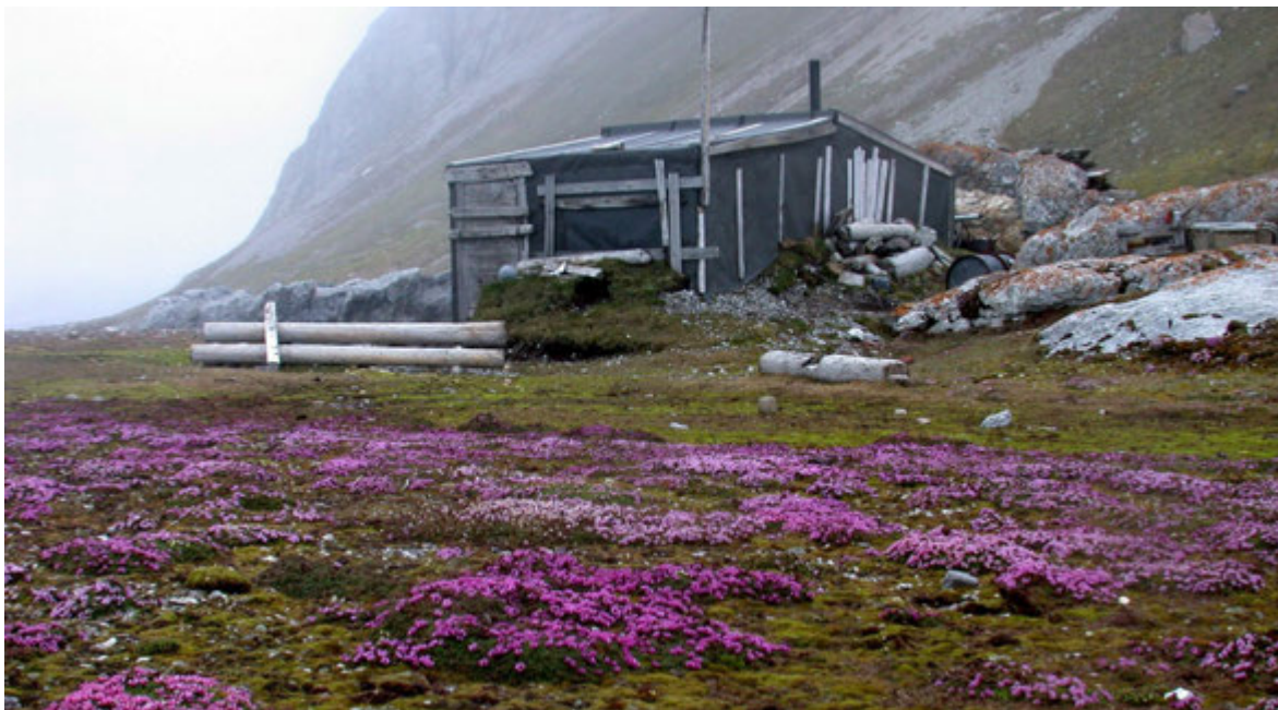
Figur 1. Mange av de fredete kulturminnene på Svalbard er enkle fangsthytter etter overvintringsfangst fra 1900-tallet. Flere av disse står med "føttene" langt nedi jorda eller har jordvoller opp over veggene som isolasjon. Dette er løsninger som gir meget stor fuktbelastning på treverket. Imidlertid er det rent kulturminnemessig en stor endring å fjerne disse, fordi det ville føre til sterk svekkelse av det autentiske ved bygge- og bruksmåten. Foto: Flyen, NIKU.
